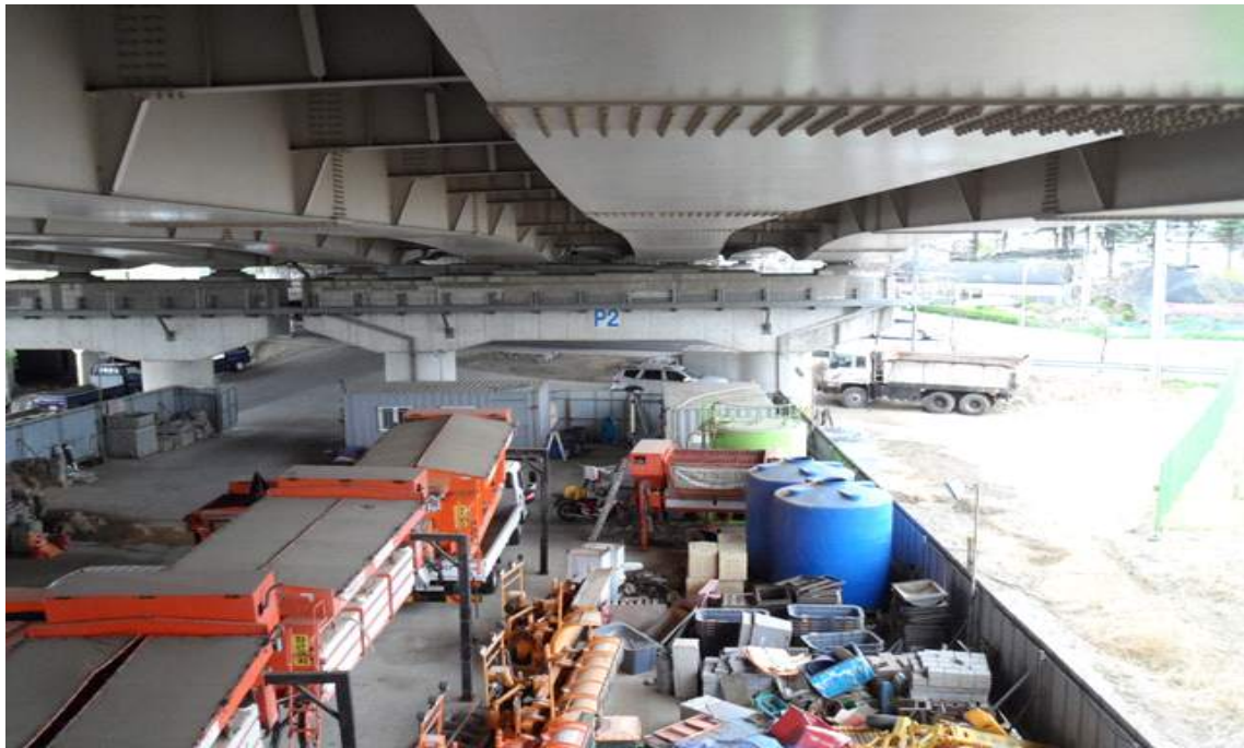
하부구조 전경 - 교각(P2)
