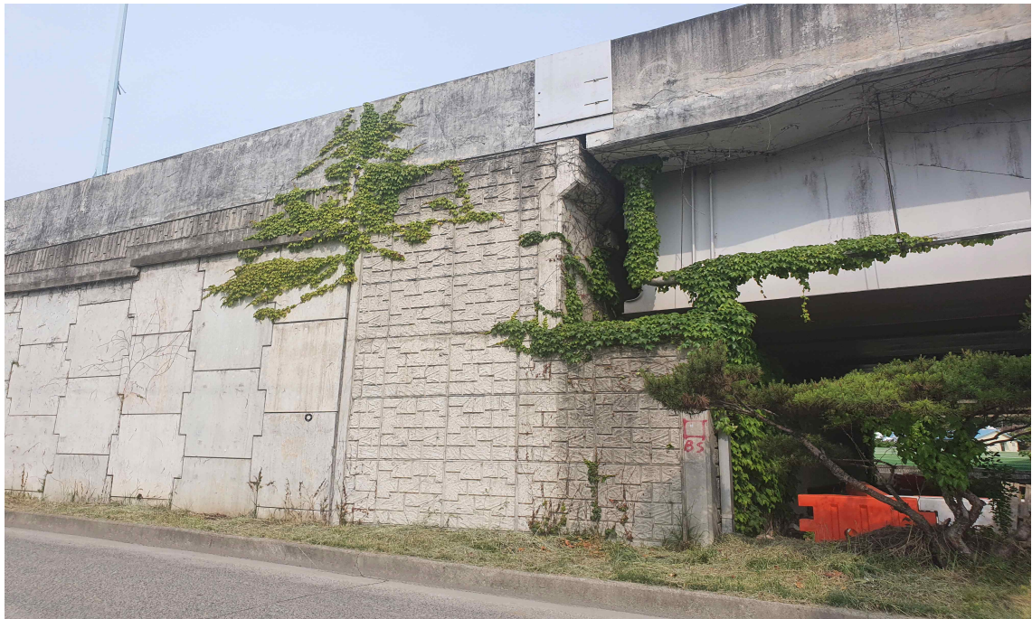
하부구조 전경 - 교대(A1)
