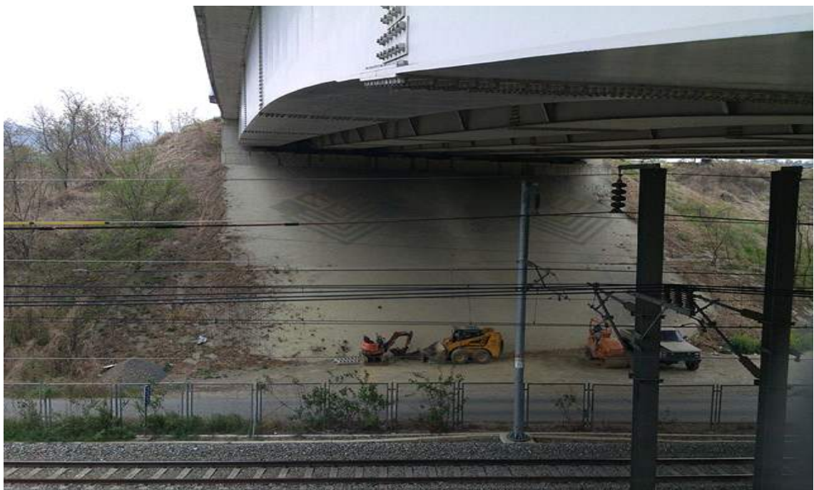
하부구조 전경 - 교대(A2)
