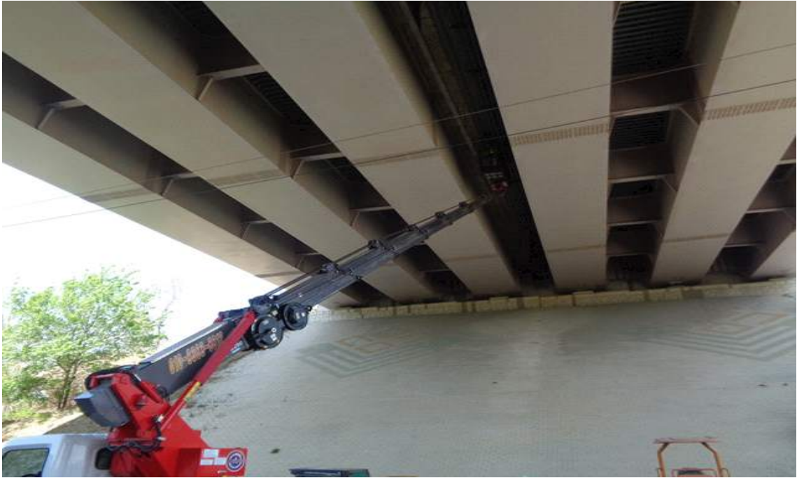
상부구조 전경 - 외부
