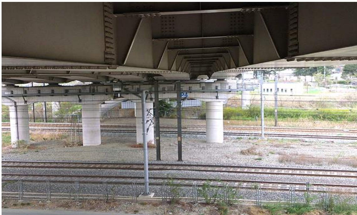
하부구조 전경 - 교각(P4)
